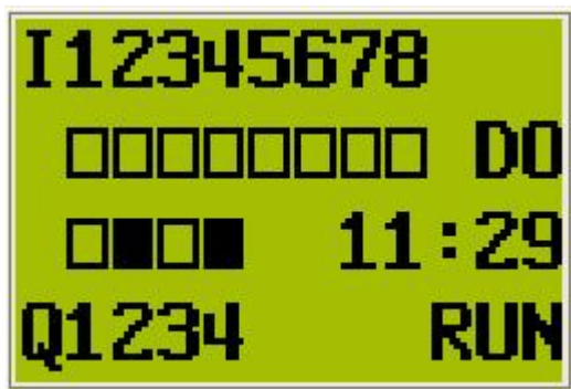
Das Display der easy-Steuerung im Standardprogramm „Zeitsteuerung“
